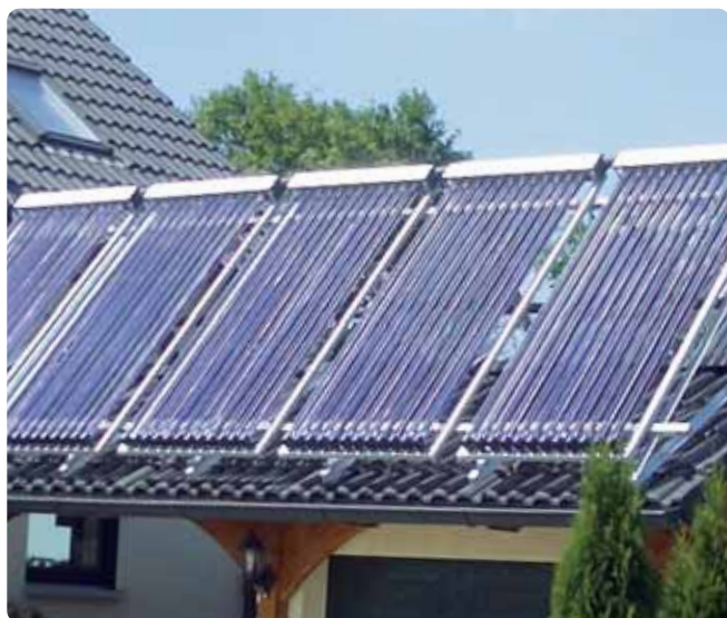
Thermische Solarflachdachanlage auf Einfamilienhaus in Leipzig.
