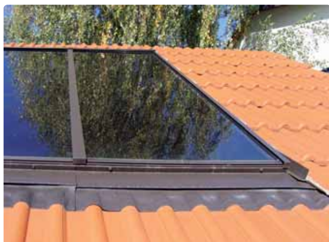
Abb.: Flachkollektoren FKI-2 als Indachmontage
